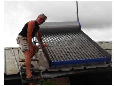
Installation du chauffe-eau solaire sur le toit des sanitaires de l'école primaire
