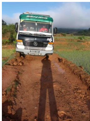
Franchissement problématique de la route digue
