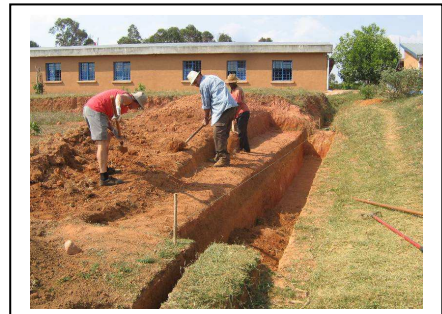
Claude et Philippe nivellent la tranchée du réservoir horizontal
